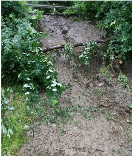
Abbildung 2: Hangrutsch Hameter Straße Richtung Hochhäuslweg
